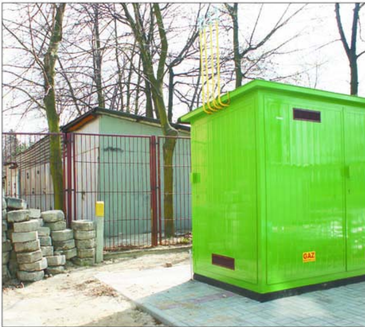
Stacja redukcyjna gazu przy ul. Armii Krajowej 7.
